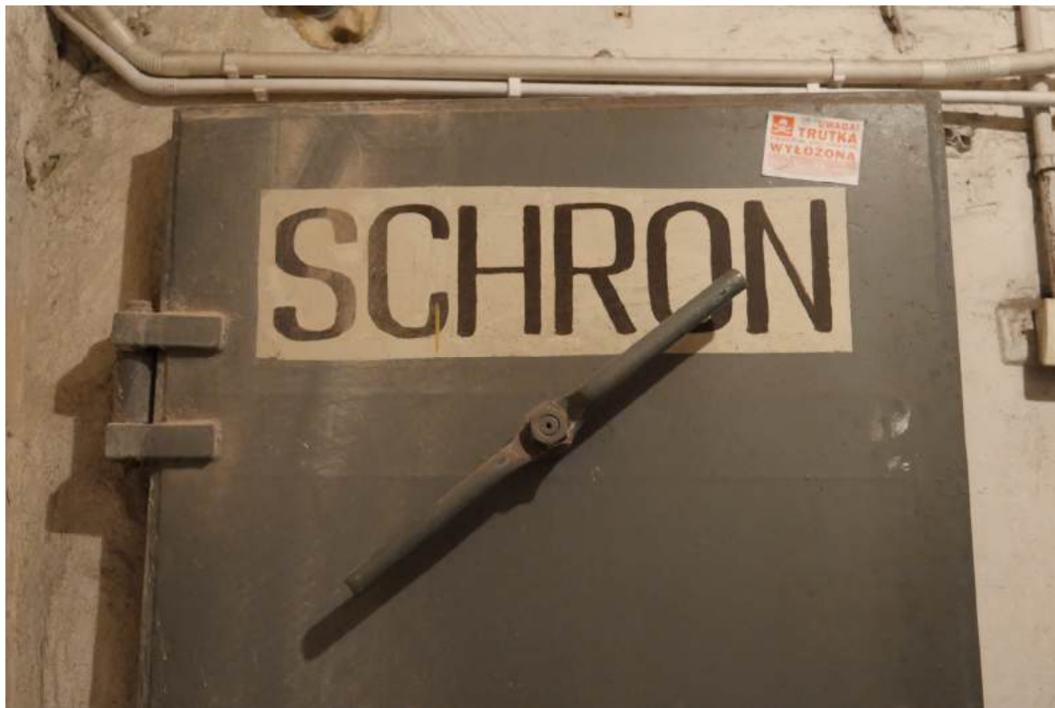
Fot. 1. Wejście do schronu w przedwojennym bloku mieszkalnym. Źródło: na podst. zdjęcia Joanny Janik.
