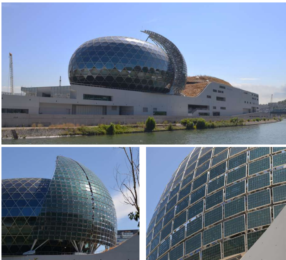
Il. 1-3. Plastyka budynku i detal Le Seine Musicale w Paryżu. Ruchomy słoneczny żagiel jako ochrona przeciwsłoneczna i wytwornik prądu. Foto: J. Figaszewski.
