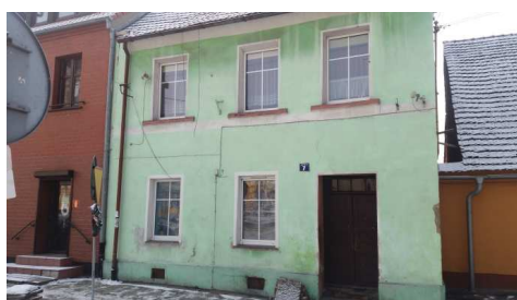
Photo 9. Building on the square Wolności 7.
